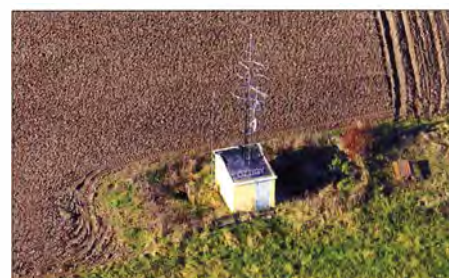
In diesem bis auf die Antennen eher unauffälligen Häuschen verbirgt sich moderne Bakentechnik. Fotos: OZ7IGY (2)
