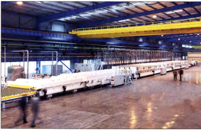
Bild 4: Heutige Beschichtungsanlagen der Von Ardenne Anlagentechnik
